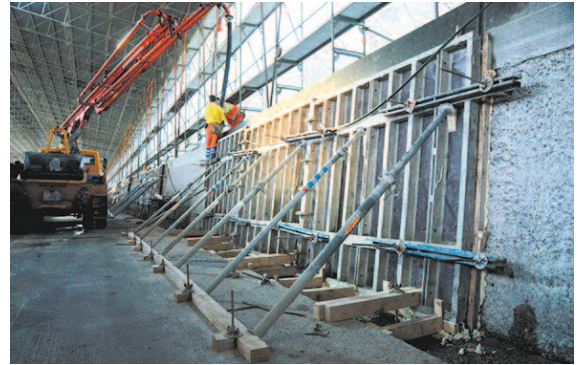
Enge Verhältnisse, einhäuptige Schalung
