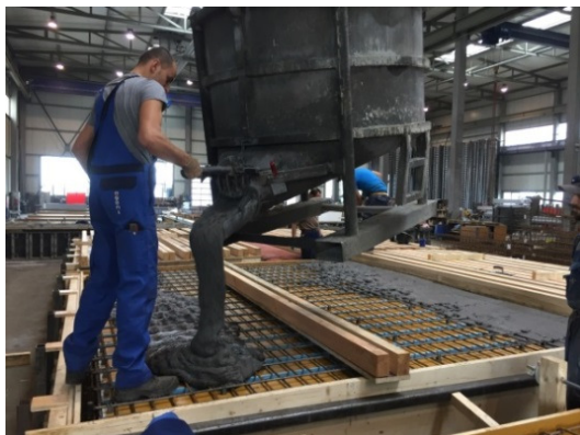
UHFB-Einbau in die geschalteten und bewehrten Elemente (Rippenplatte, Seitenträger) im Bild links, rechts ausgeschaltete Rippenplatte (Foto H.-P. Felder, alphabeton)
