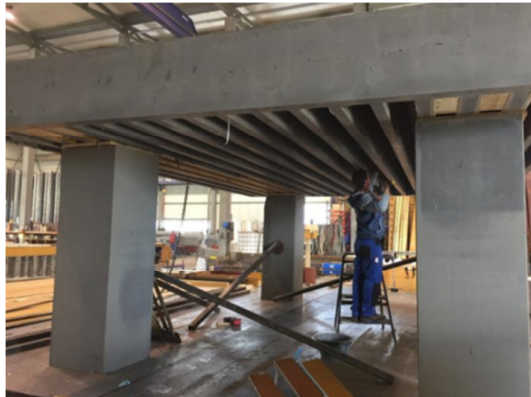
UHFB-Einbau in die geschalteten und bewehrten Elemente (Rippenplatte, Seitenträger) im Bild links, rechts ausgeschaltete Rippenplatte (Foto H.-P. Felder, alphabeton)
