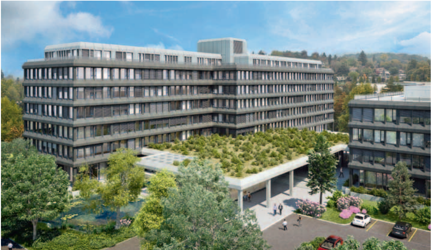
MURIFELD | In der modernisierten und revitalisierten Überbauung sind die meisten Büroflächen bereits wieder vermietet.
