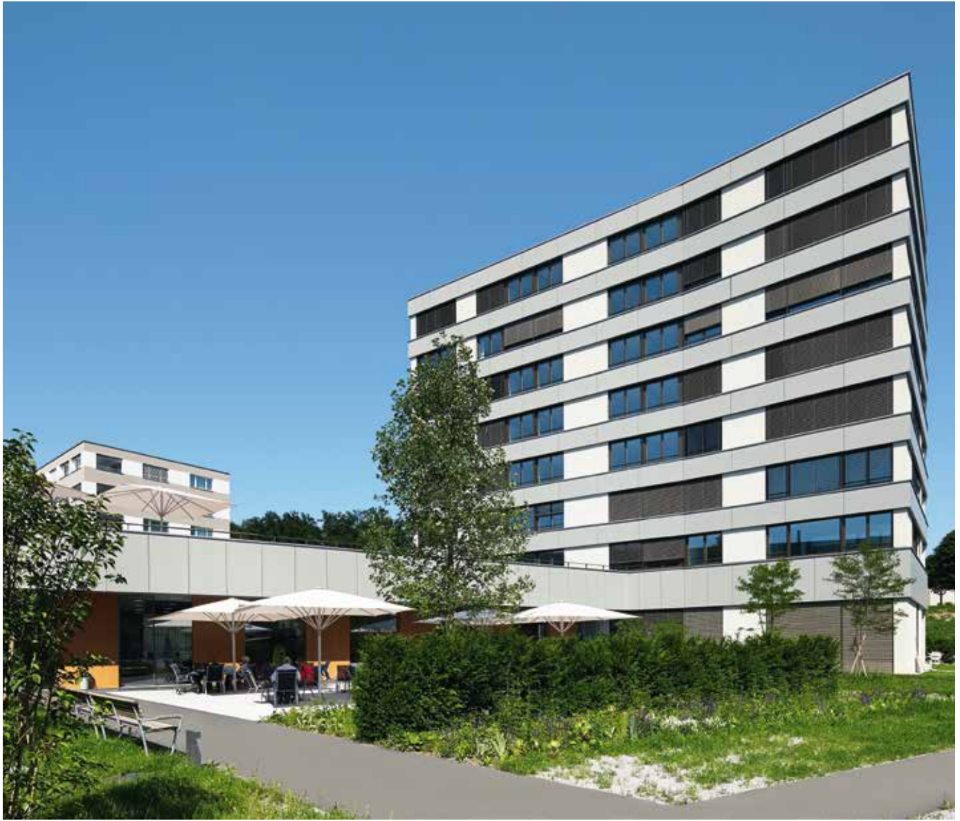
Das Vitadomo Seniorenzentrum befindet sich ganz in der Nähe des Stadtzentrums von Opfikon/Glattbrugg.
