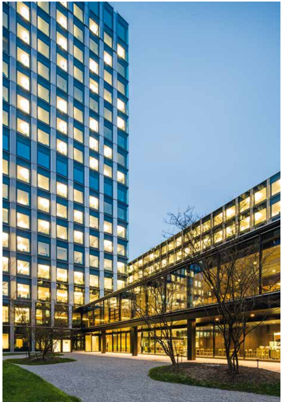
SKYKEY | Der neue Vorzeigehauptsitz von Zurich Schweiz wurde 2014 offiziell eröffnet.
