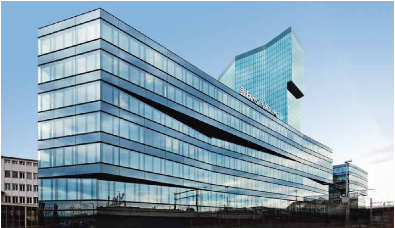
PLATFORM, ZÜRICH | Mit einem hohen Anteil an jungen Liegenschaften an ausgezeichneten Lagen ist Swiss Prime Site auch für die Zukunft optimal positioniert.
