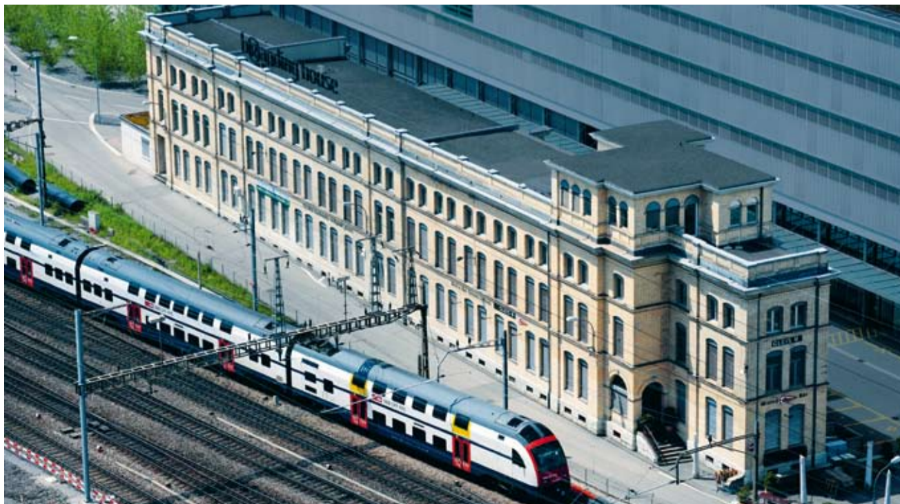
Das 6200 Tonnen schwere MFO-Gebäude wird im März 2012 auf Rollen 60 Meter nach Westen verschoben.
