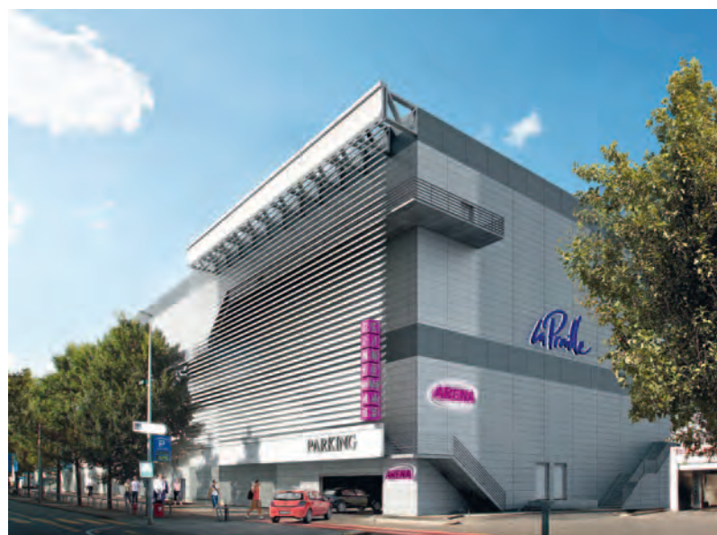
La Praille in Grand-Lancy, auf dem Dach entsteht ein Multiplexkino.
