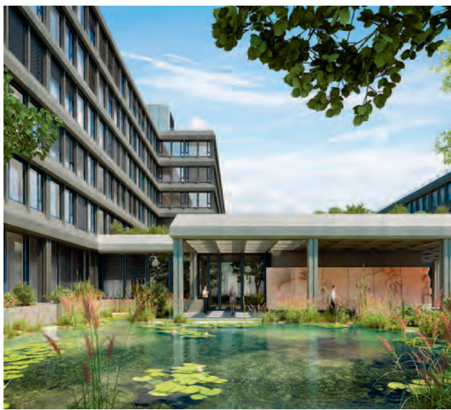
Das Gebäude Murifeld in Bern wird bis Ende 2013 saniert und modernisiert.
